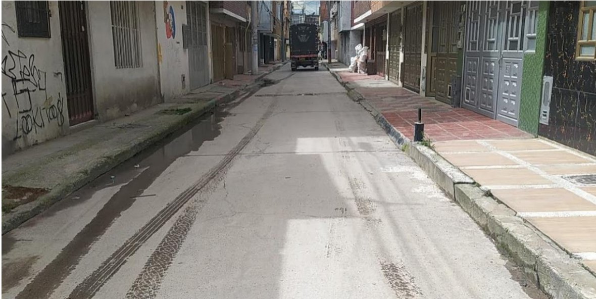
CALLE 71 entre CARRERA 86A y CARRERA 87
