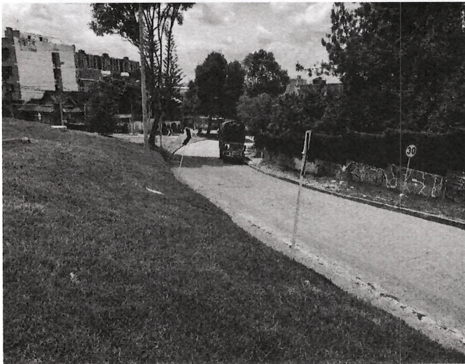
FOTO 5. CRUCE Avenida Calle 191 entre Carrera 7 y Carrera 7A (Tramo 1) VISTA: Oriente – Occidente
