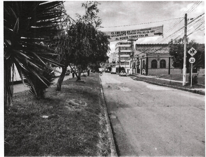
FOTO 2. VISTA SEPARADOR / CALZADA – ORIENTE - OCCIDENTE
