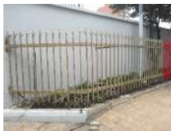
Anclaje y soldadura de reja en jardín calle 24.
