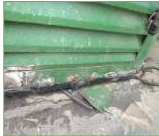
Reforzamiento estructural puerta bodega de bombas (Soldadura y pintura)
