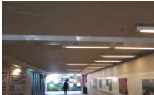
Limpeza de canaletas y techos en policarbonato
