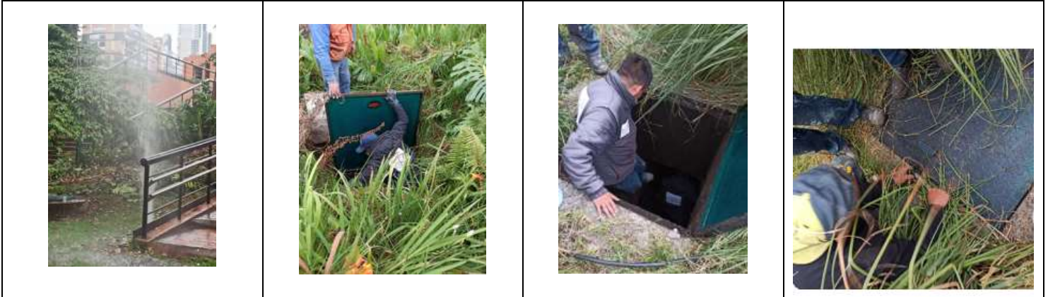
Mantenimiento a tanques sistema de riego
