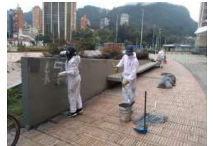
Pintura de muros
