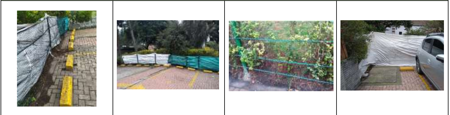
Protección en lona y cuerdas para el cercamiento del parqueadero
