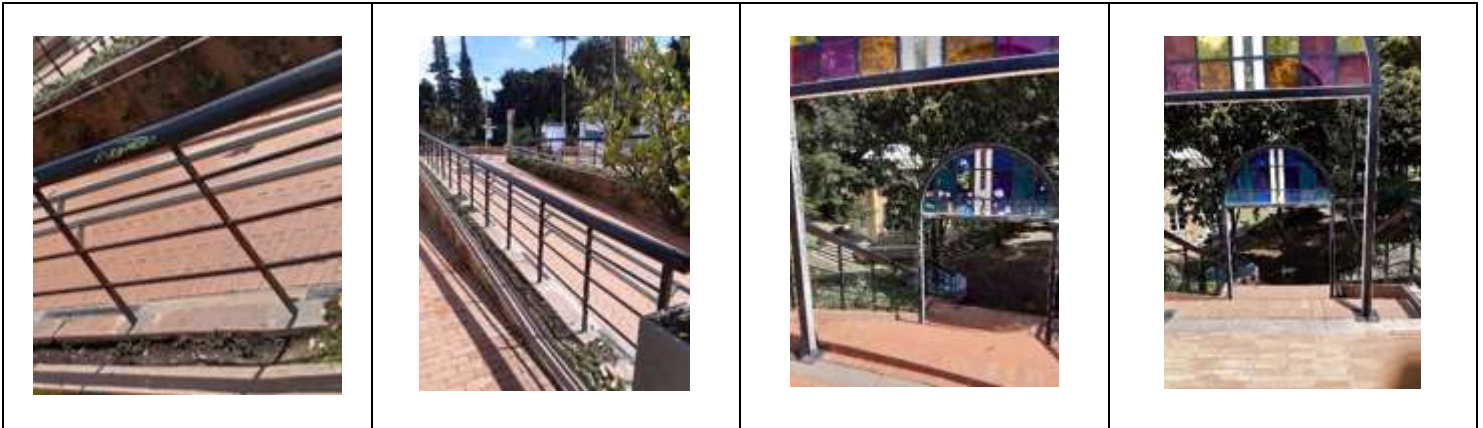
Reparación e instalación señalética informativa y mobiliario
