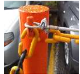
Instalación cercamiento tipo (Tubo + guaya + cadena) en la Bahía occidental
