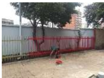
Instalación y elaboración de reja de 9 metros en acero con pintura.
