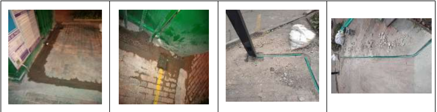
Instalación red de fibra optica para camaras de parqueadero
