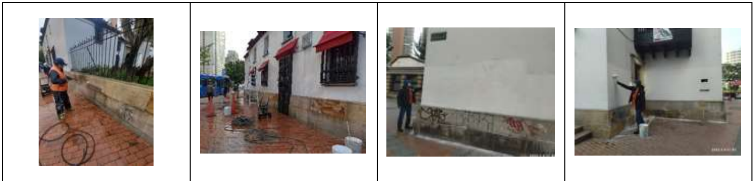
Limpeza y mantenimiento fachadas Iglesia San Diego
