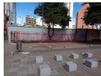
Pintura de dados en concreto.
