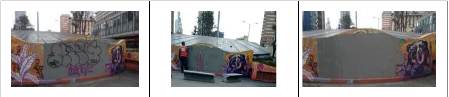
Rectificación de grafitis y pintura de muros
