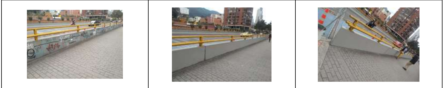
Limpeza y pintura de puente Calle 26 Cra 7
