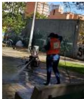
Hidrolavado de andenes y adoquines.
