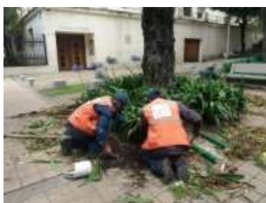
Instalación cercamientos y reparación de cajas
