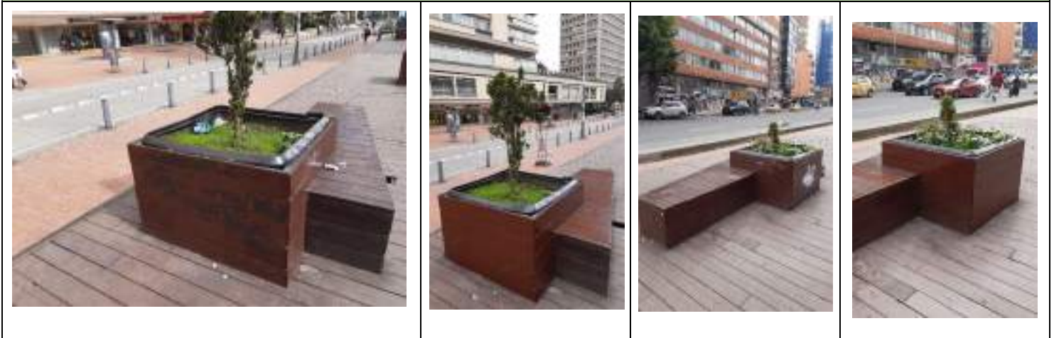
Mantenimiento de pintura gris basalto
