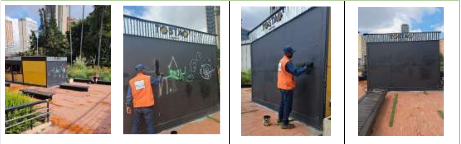
Mantenimiento de bodega
