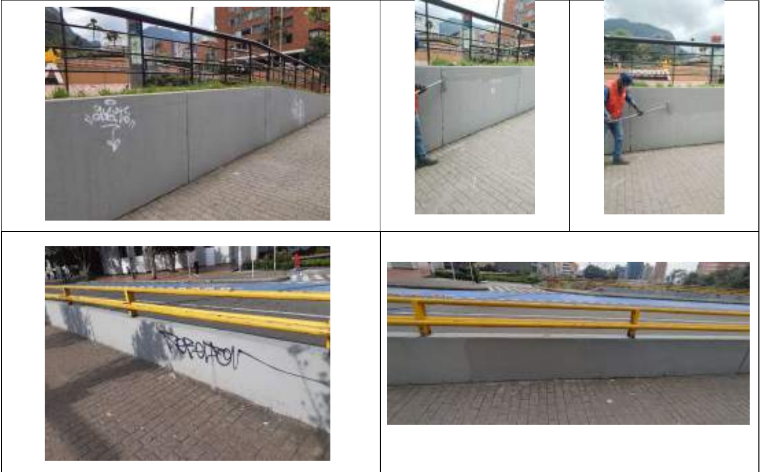
Pintura de materas, muros y elementos terracota
