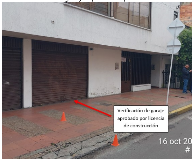
Imagen 3. Verificación de garaje aprobado por licencia de construcción
