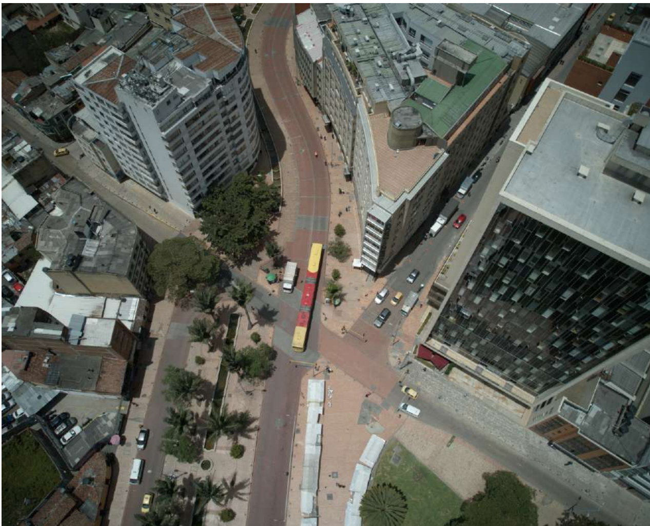
Calzada mixta y exclusiva de Transmilenio colindan en el eje ambiental. DADEP 2021
